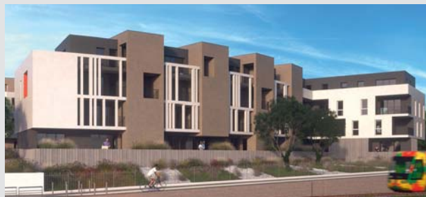
Résidence des Grisettes à Montpellier, une construction passive de 35 logements sociaux.
