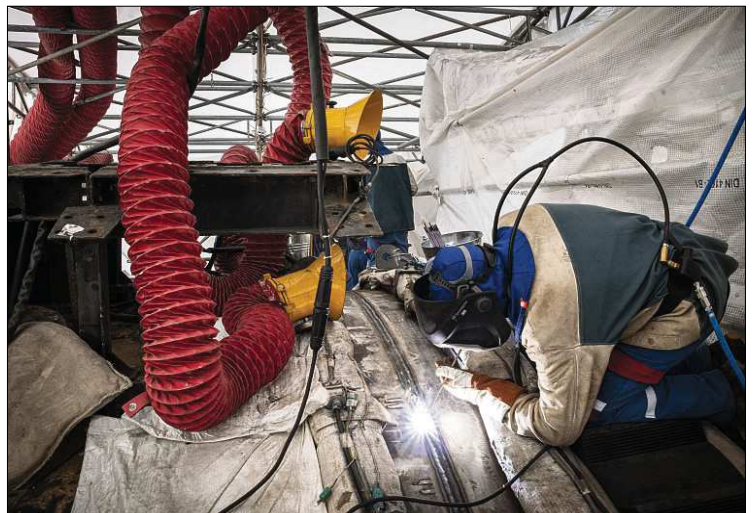
Grâce à l'expertise – notamment en soudure – du chantier cherbourgeois de Naval Group, spécialisé dans la construction des sous-marins depuis plus d'un siècle, le SNA Perle est en passe d'être réparé.
