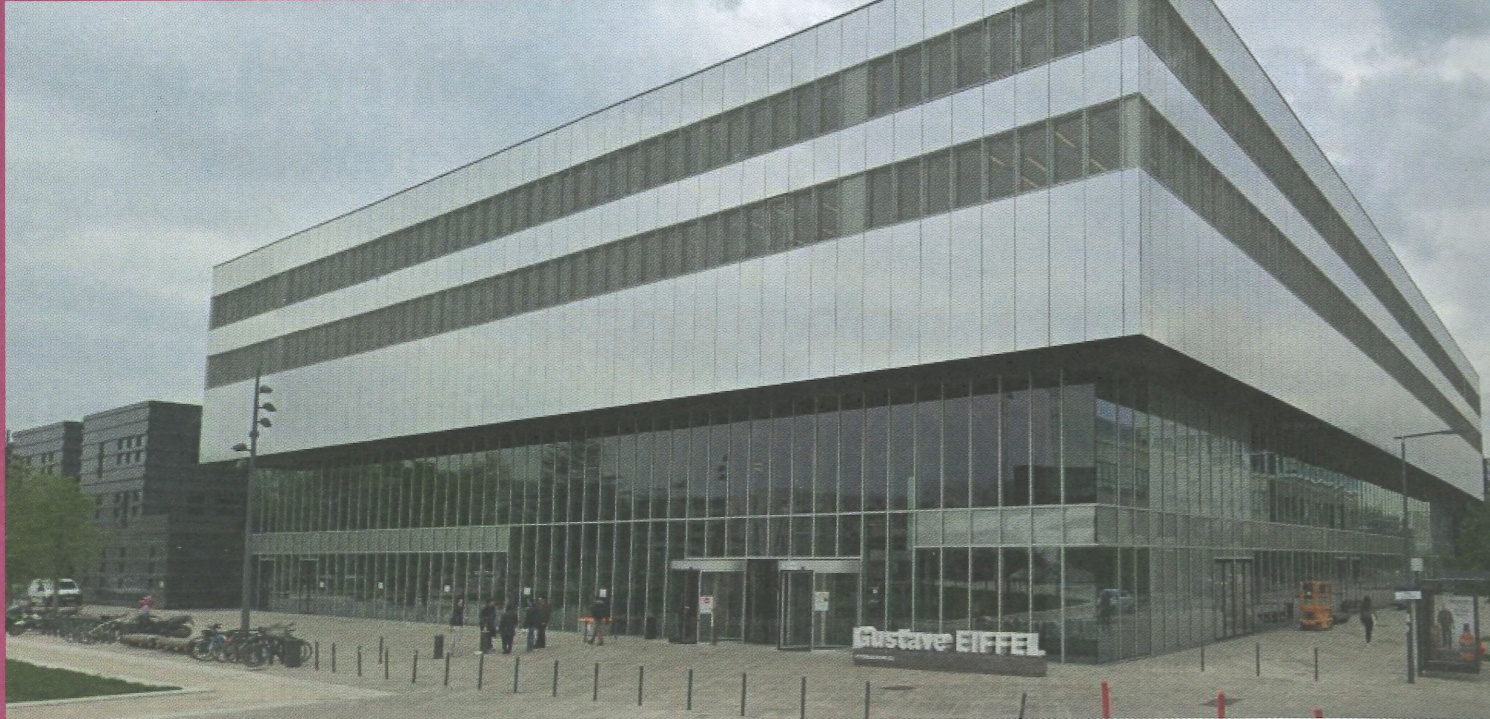
Le nouveau bâtiment Gustave Eiffel du Campus Paris Saclay à Gif-sur-Yvette.
