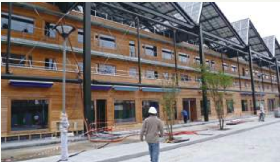
Réalisation du bardage bois de la Halle Pajol à Paris, en 2013.
