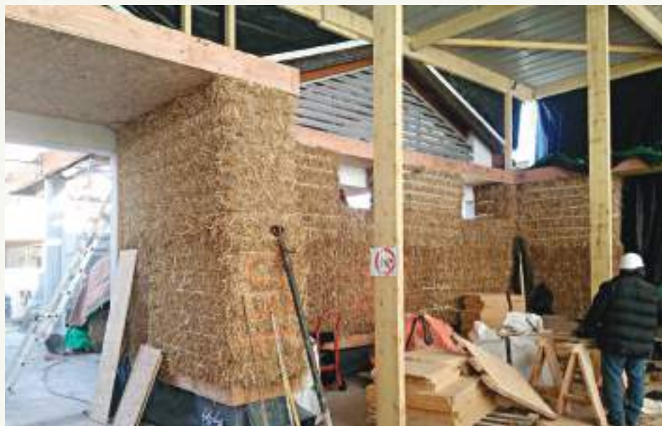
Construction en paille porteuse d'un groupe scolaire à Rosny-sous-Bois, en 2017.
